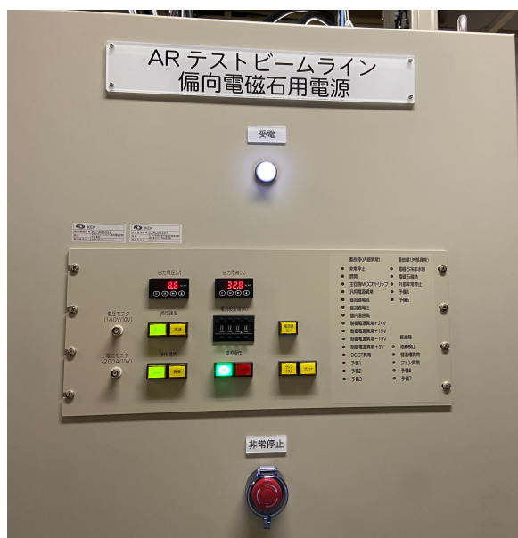
図 3.7: 新 B 電源。EPICS によってリモートコントロールが可能。
